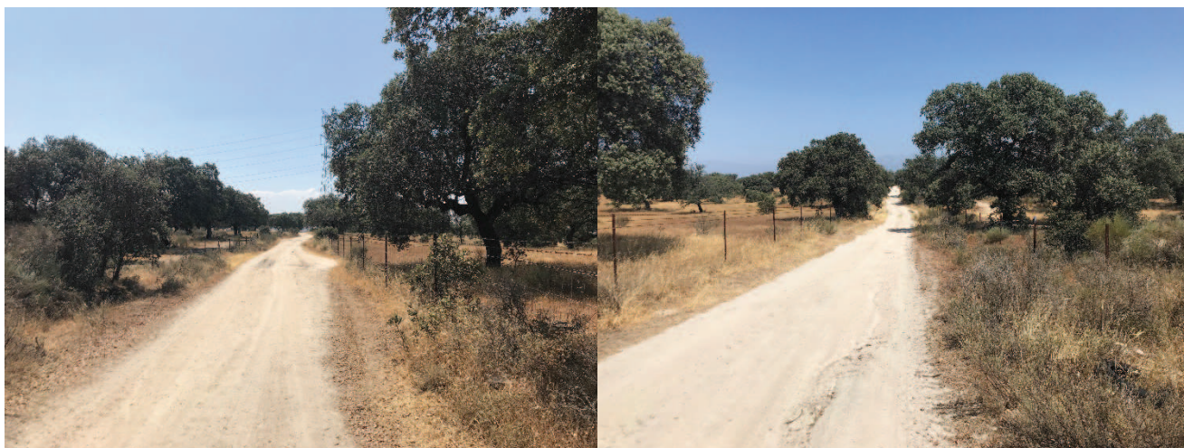
PUNTO 9: ZANJA DIRECCIÓN SUBESTACIÓN. ZANJA DIRECCIÓN PLANTA SOLAR
