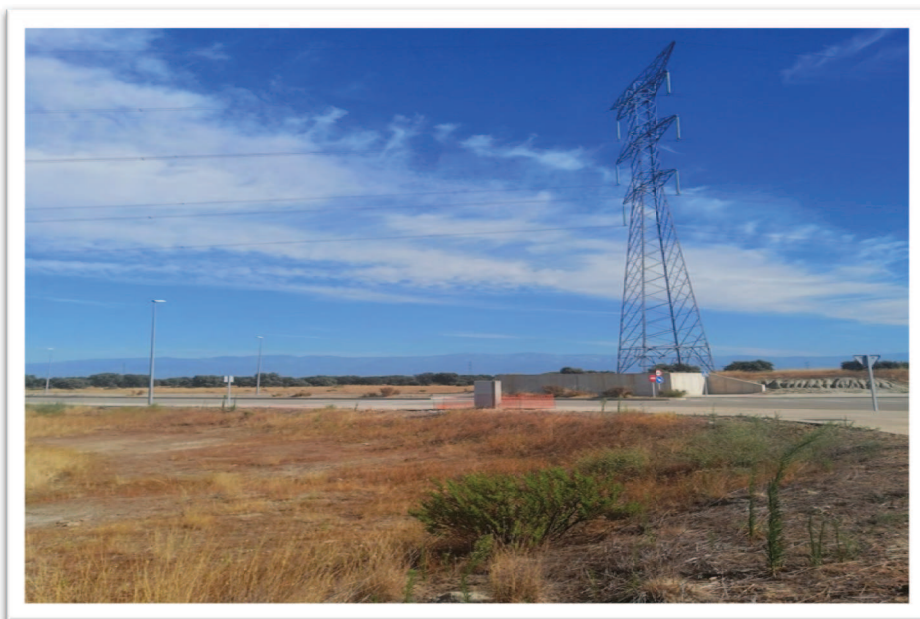
Fig.3. Final de la bifurcación a la derecha de la línea de evacuación.
