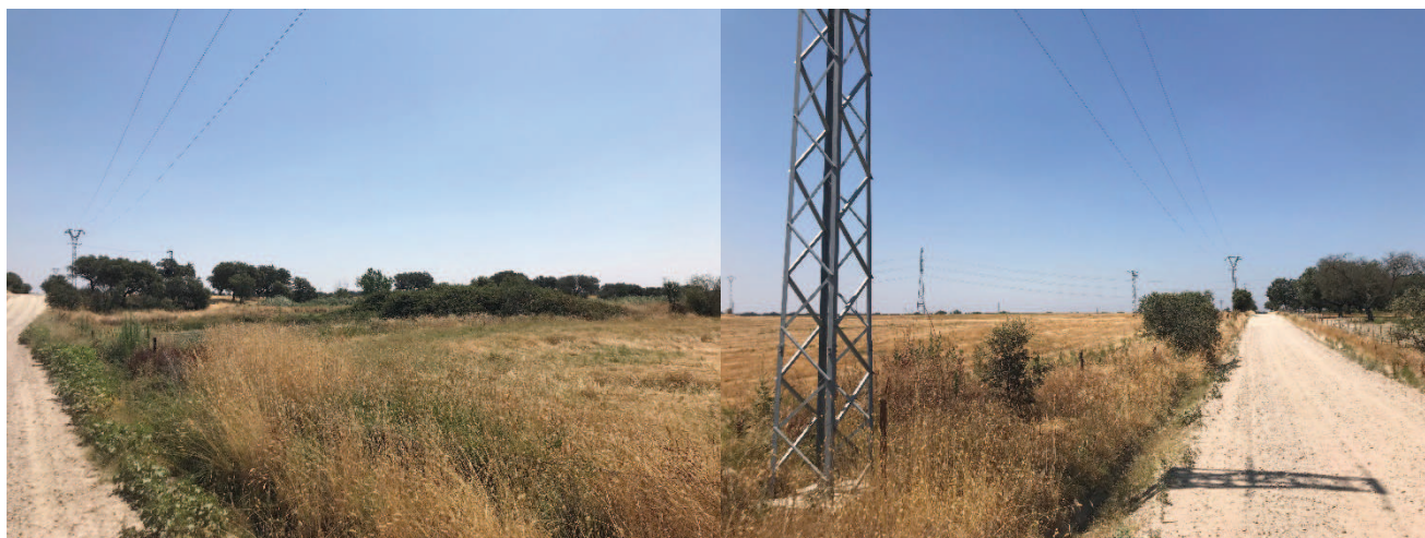
PUNTO 3: ZANJA DIRECCIÓN PS ST. ZANJA DIRECCIÓN PLANTA SOLAR NAVALMORAL 1
