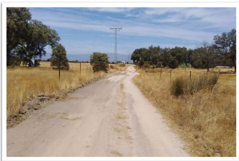
Fig.12. Tramo final de la línea de evacuación que retoma el camino.
