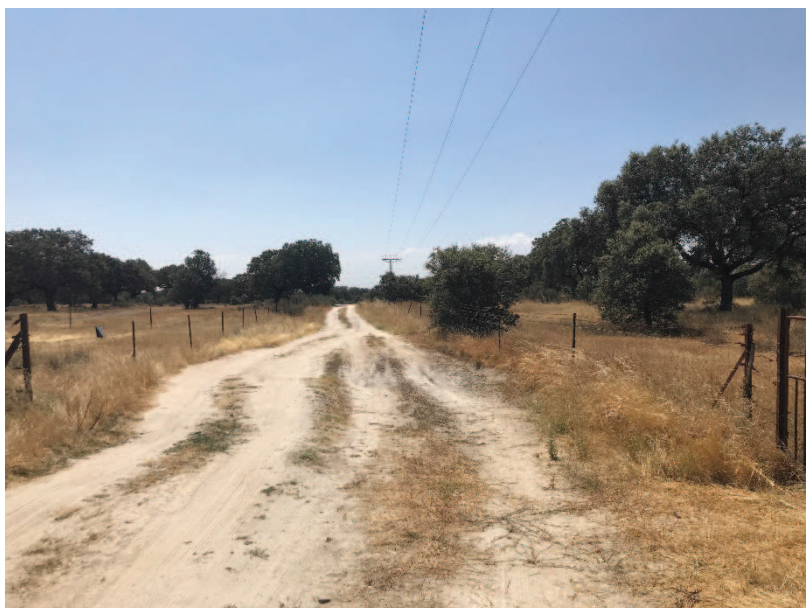
PUNTO 6: ZANJA DIRECCIÓN SUBESTACIÓN. ZANJA DIRECCIÓN PLANTA SOLAR
