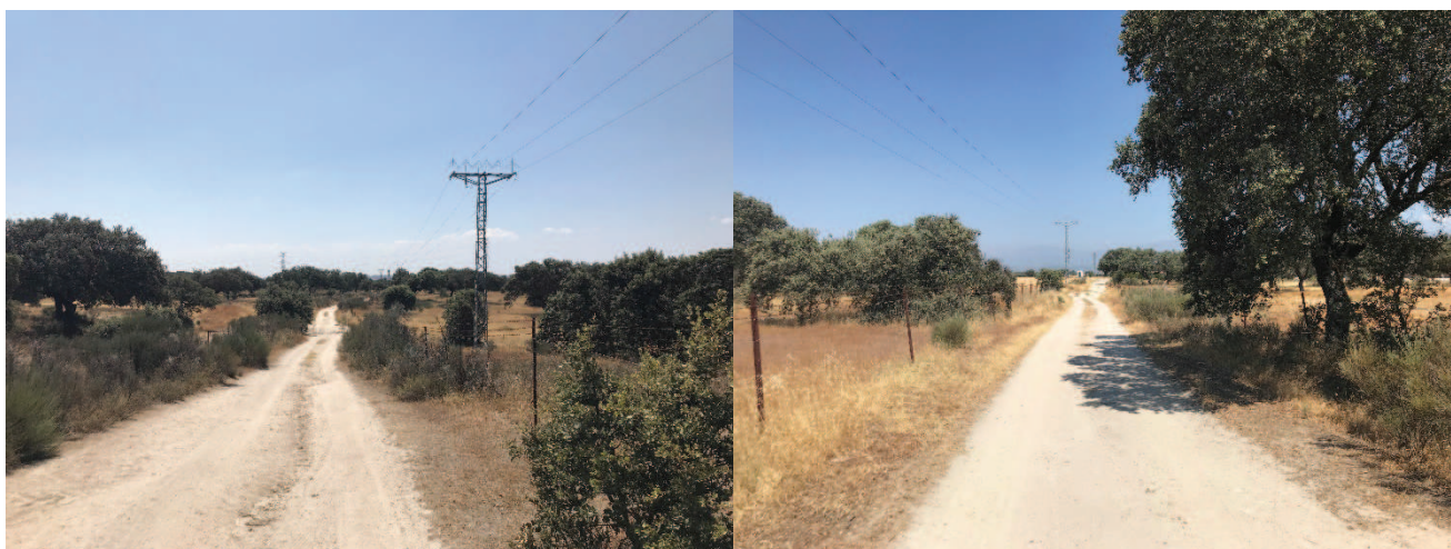
PUNTO 7: ZANJA DIRECCIÓN SUBESTACIÓN. ZANJA DIRECCIÓN PLANTA SOLAR
