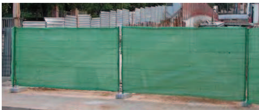
Figura 7. Ejemplos de vallado de obra móvil para minimizar la interacción visual entre la fauna y la actividad constructiva del proyecto.
