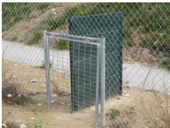
Figura 10. Ejemplo de paso de fauna de hoja basculante en un vallado perimetral.
