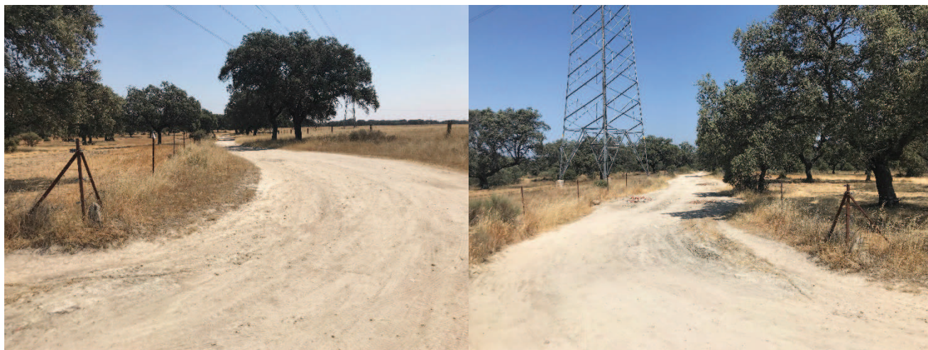
PUNTO 10: ZANJA DIRECCIÓN SUBESTACIÓN. ZANJA DIRECCIÓN PLANTA SOLAR
